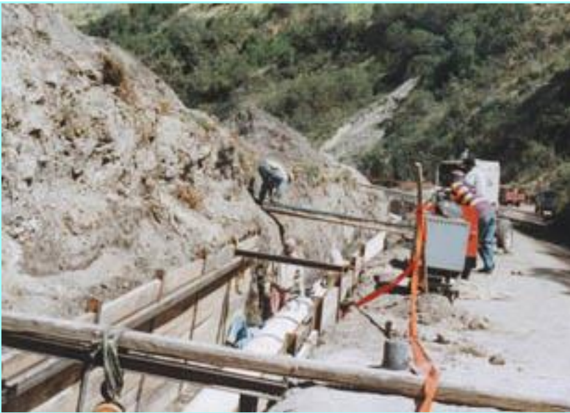
Entibado de zanjas
