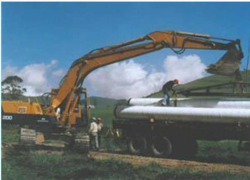
Transporte de tubería
