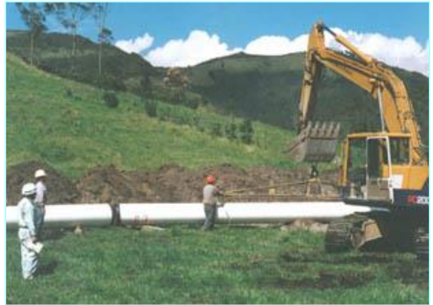
Ubicación de tubería
