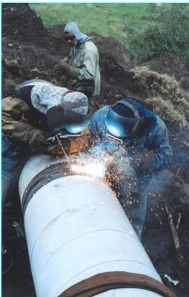
Soldadura API-1104, Inspección radiográfica
