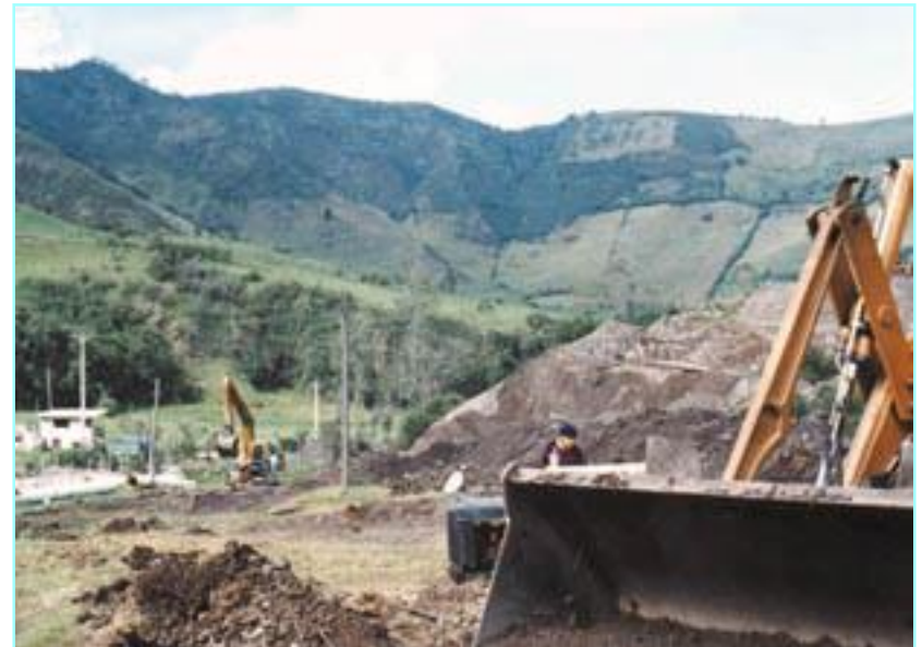
Construcción de zanjas
