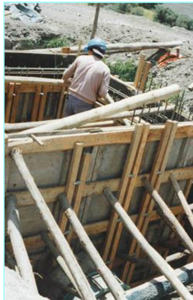
Cámaras de hormigón visto para alojar válvulas.
