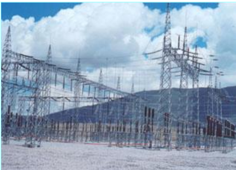
Vista panorámica del patio de 230 KV, en construcción
