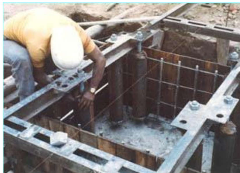
Instalación de los pernos de anclaje para hormigonado
