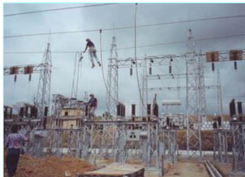
Instalación cable aéreo desde barras hacia los equipos
