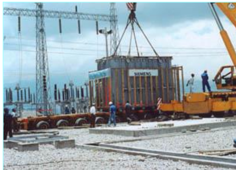
Descarga del transformador de 300 MVA, 230 KV
