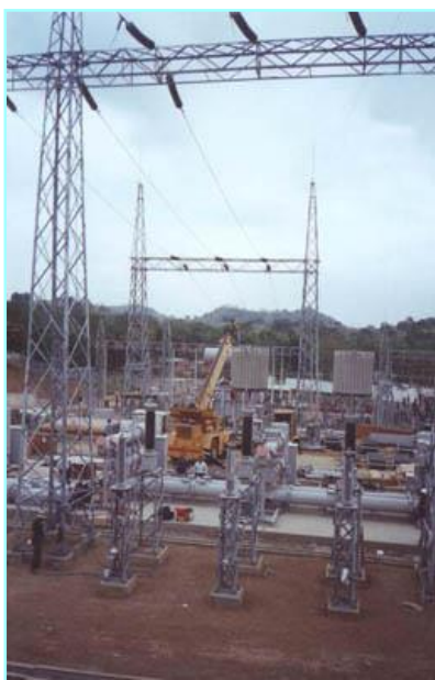
Instalación trampas de onda y transformadores de potencial de 138 KV
