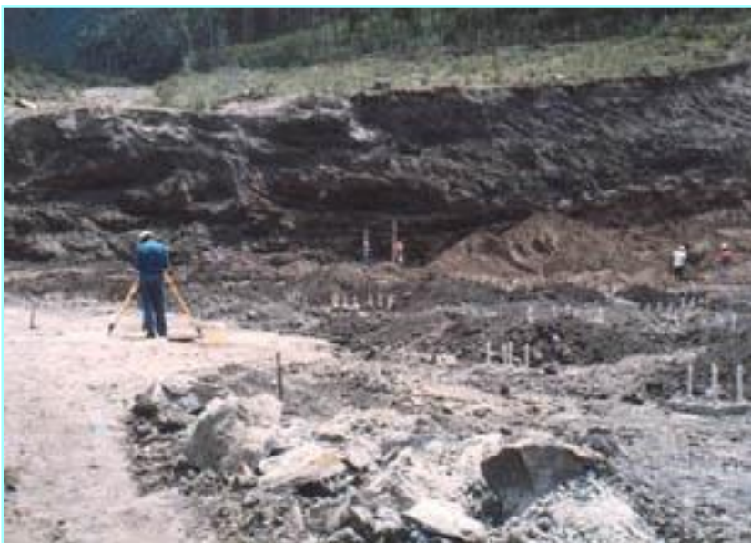
Excavación e inicio de obras civiles
