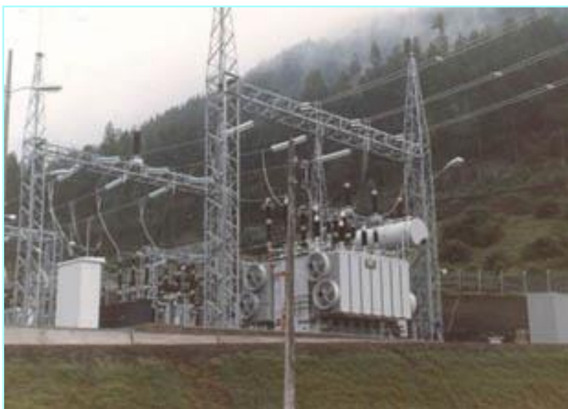
Montaje de transformador trifásico de 100 MVA, 138/46/KV
