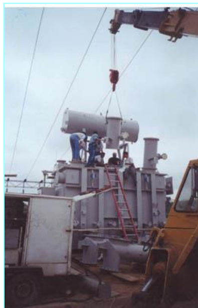
Montaje del transformador de 40/50/60 MVA, con LTC
