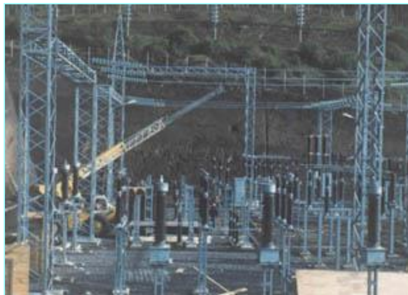
Montaje de estructuras, cableado aéreo y aisladores
