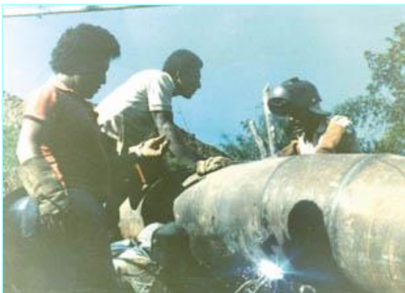
Minicentral “El Estado”, 2 x 0.85 Mw, Tubería de Presión 36”, Obras Civiles
